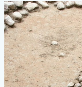
Naturalne podłoże glębwe wzmocnione litą warstwą gliny
